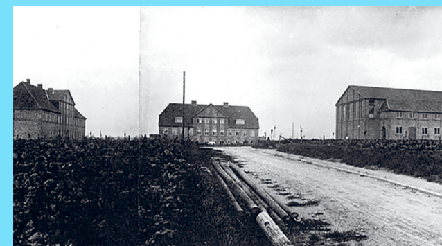
Elektricitetsværket i Svinninge anno 1914 omgivet af roemarker. Direktørboligen ses i midten, funktionærbygningen til venstre og maskinhallen til højre.
